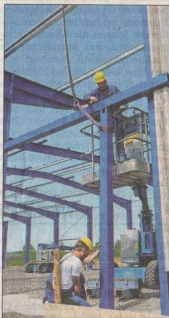
Spezialisten der Wegra GmbH bei der Montage der Halle.
