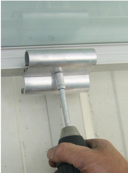
Abbildung 45: Montage „Modulbefestiger-Set“ vorne
