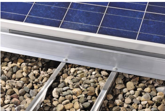
Abbildung 44: Kiesballastierung in der Grundschiene 230 - 90
