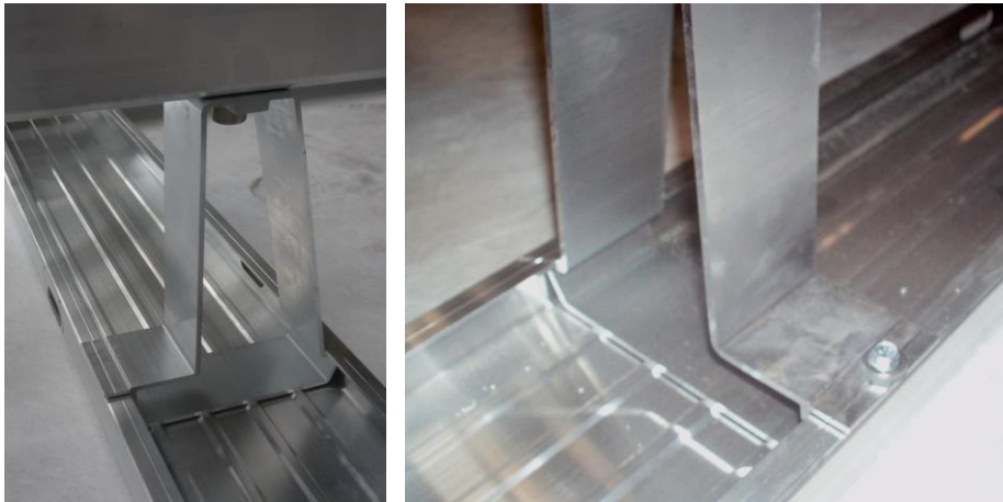
Abbildung 58: Stützen-Set in Grundschiene
