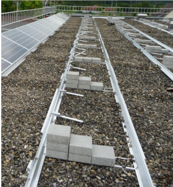
Abbildung 30: Eingelegte Modulstützen-Set
