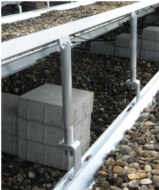
Abbildung 31: Höhenverstellbare Modulstützen
