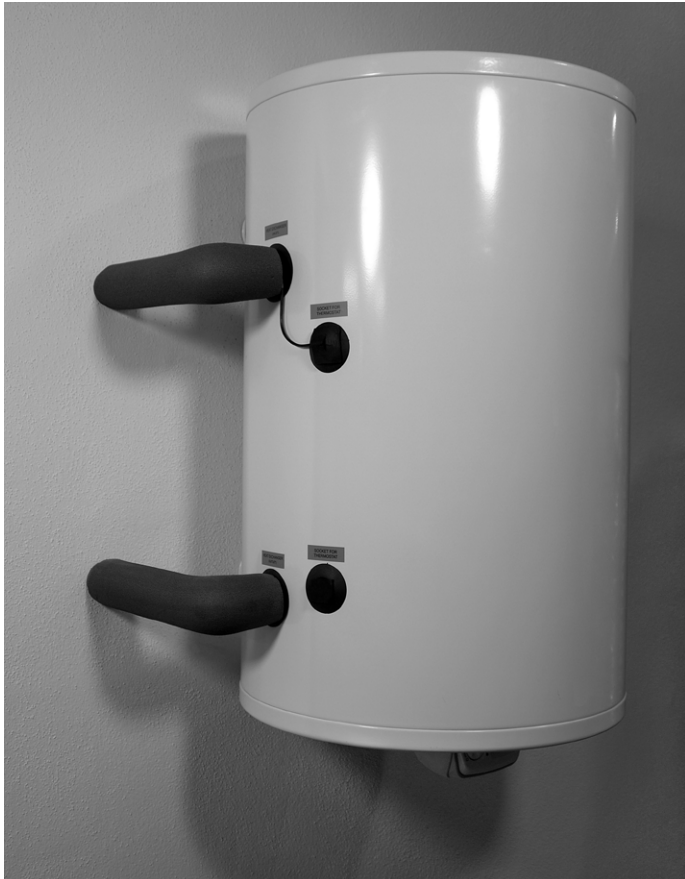
Abb. 13 SELACAL-Solarspeicher mit Verrohrung zum Heizkessel
