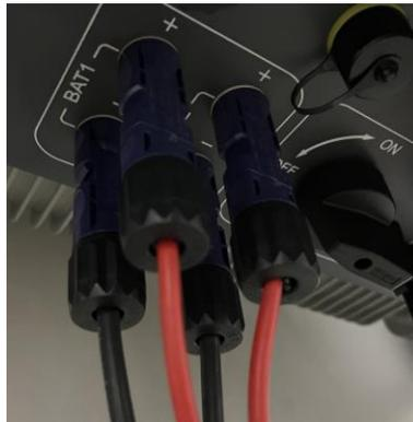
Abbildung 24: Parallelanschluss Batterie an beide Batterie-Eingänge
