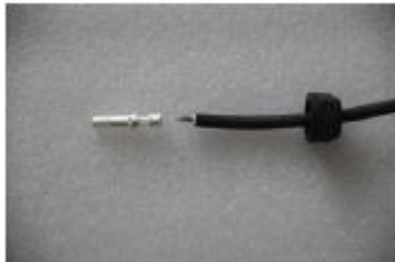
Abbildung 9: Kabel in die Steckerkappe einfügen
